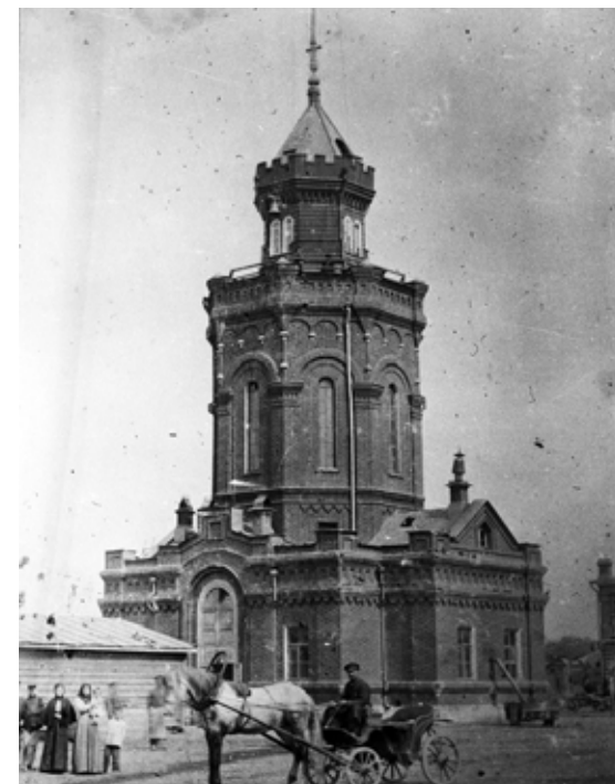
Водонапорная башня противопожарного водопровода построенного в г. Шуя в 1883 году по проекту В.О.Шервуда.
